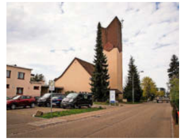
Die katholische Kirche Hinwil wird für 1,78 Millionen Franken saniert. Archivfoto: Seraina Boner
